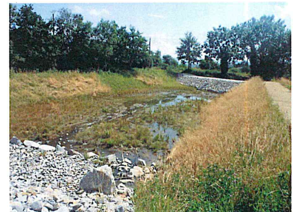
Bassin de rétention
