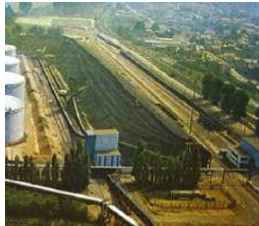
Cuves de stockage des matériaux combustibles acheminés par les voies de communication (voies ferrées, routes, voies navigables)
