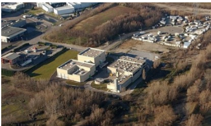
La station d'épuration de Givors, implantée en bordure du Rhône
